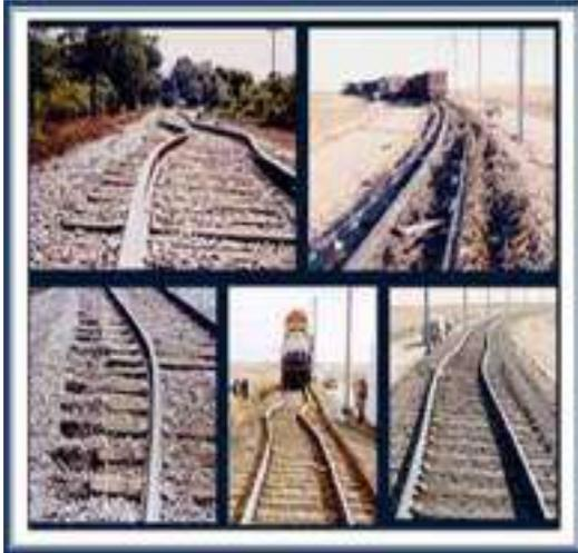
شكل 5-7 انحناء خطوط السكك الحديدية بسبب التمدد الحراري.
